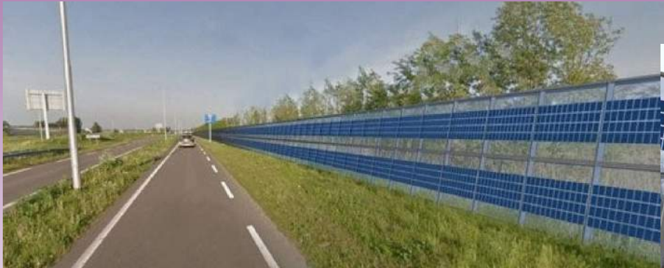
Geluidscherm met zonnepanelen, proefproject van 480 meter in gemeente Pijnacker-Nootdorp, langs de N470. Ontwikkeld met BAM Infra
