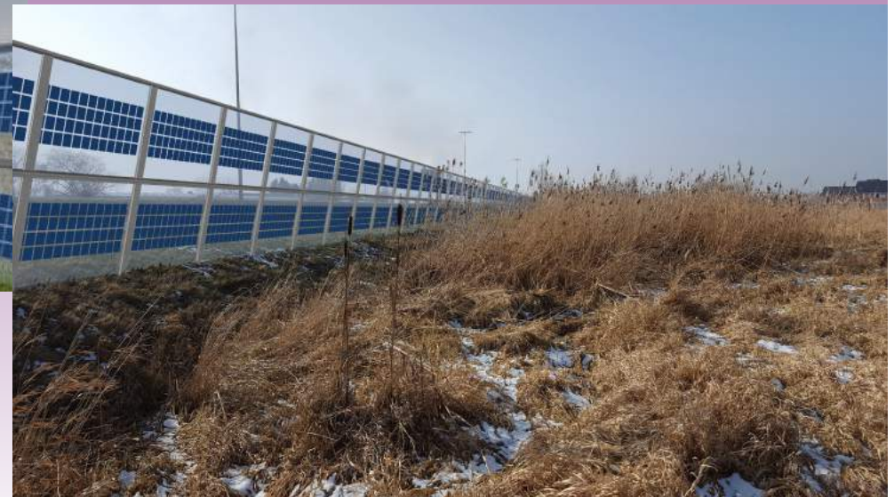
Geluidscherm met zonnepanelen, proefproject van 480 meter in gemeente Pijnacker-Nootdorp, langs de N470. Ontwikkeld met BAM Infra
